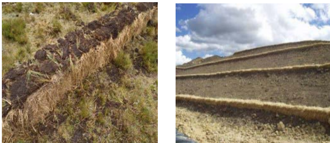
Imagen 23: Fotografías de uso de pacas de paja para el control de sedimentos, (izquierda) la colocación de champas sobre la paca de paja se usa como protección contra animales de pastoreo en busca de alimento.
