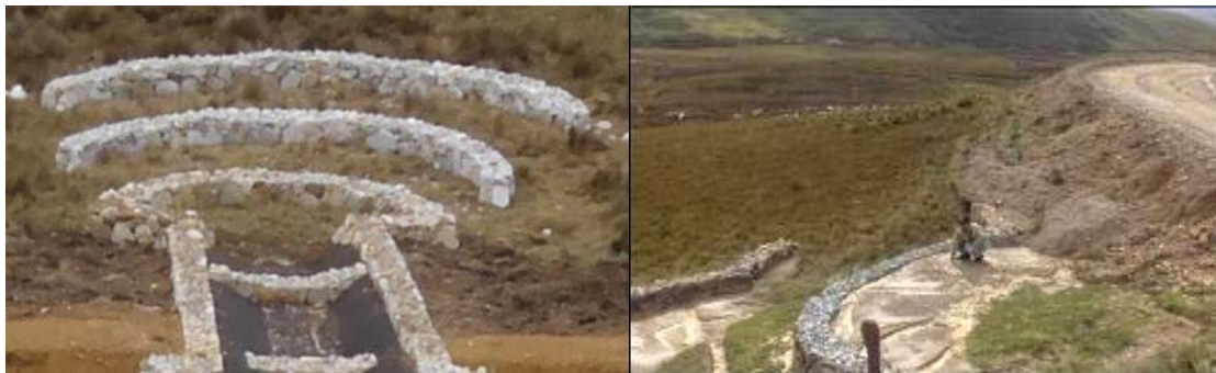
Imagen 13: Fotografías del uso adecuado de barreras para el control de sedimentos
