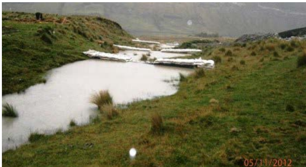
Imagen 9: Fotografía de check dam con vertederos
