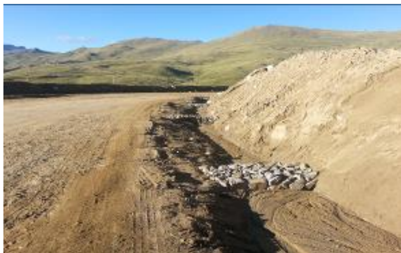
Imagen 7: Fotografía de aplicación de control ambiental check dam para canales en vía de acceso.
