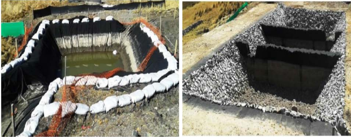
Imagen 29: Fotografías de implementación de pozas de sedimentación, donde se observa que la entrada y salida de las pozas se encuentran en sentido contrario para incrementar el tiempo de retención.
