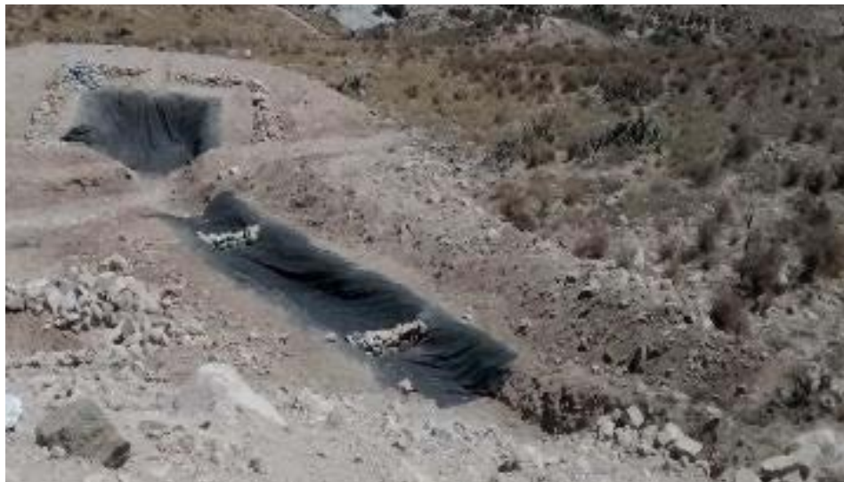
Imagen 11: Fotografía de disipador de energía
