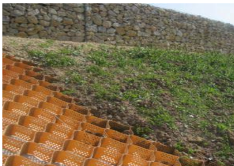
Imagen 17: Vista de uso de geoceldas para prevención de generación de erosión o cárcavas.
