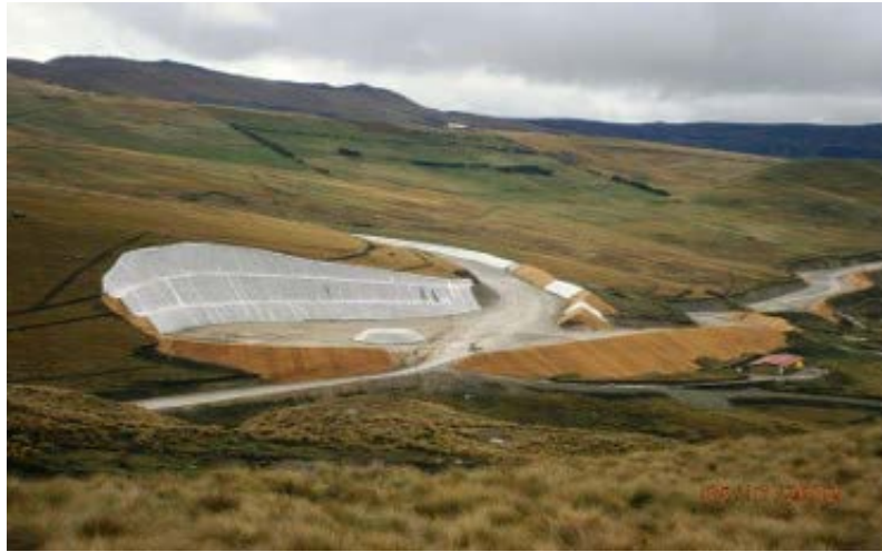
Imagen 20: Fotografía de protección de erosión y control de sedimentos, empleando una biomanta.
