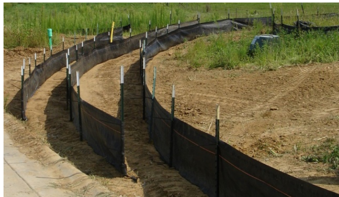
Imagen 16: Ejemplo de uso de silt fence con extremos rotados – debe ser los dos extremos y debe usar un corte mas largo
