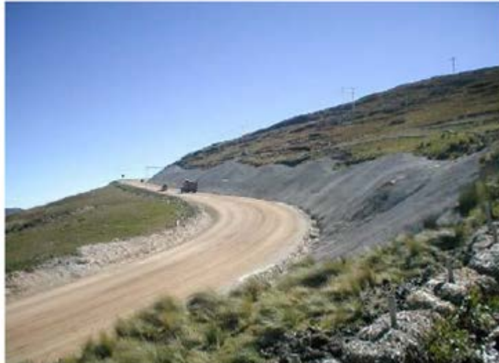
Imagen 18: Fotografía de uso de concreto lanzado sobre un talud para el control de la erosión
