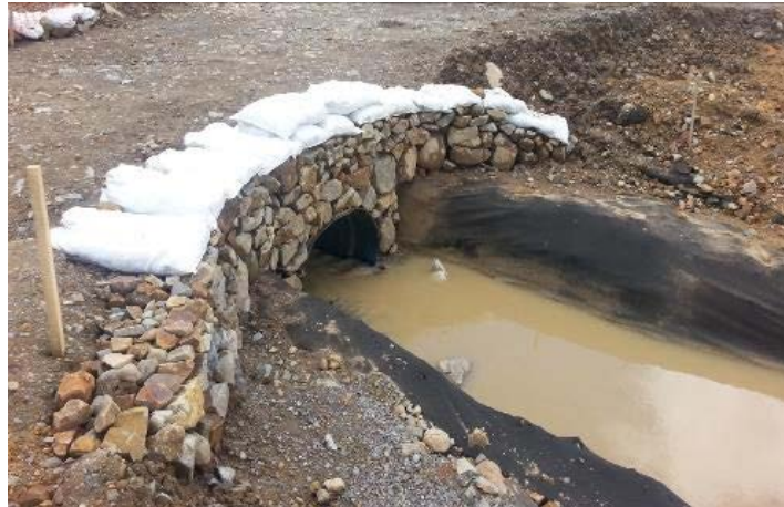
Imagen 27: Fotografía de alcantarilla de paso con enrocado y protección de geotextil
