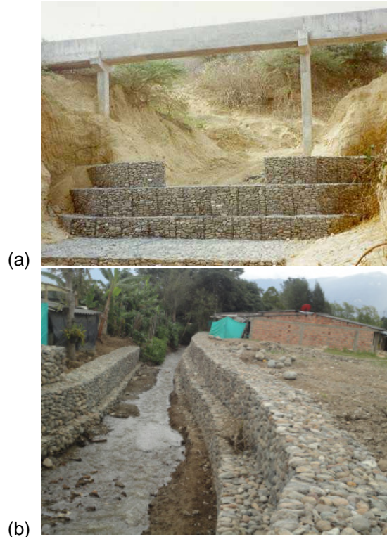
Imagen 30: Fotografía (a) control de sedimentos mediante dique de gaviones en una quebrada, fotografía (b) control de erosión mediante construcción de gaviones en el talud.
