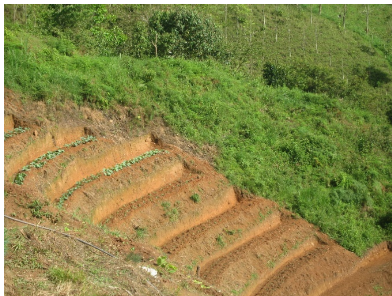
Imagen 2: Prevención de erosión mediante conformación de terrazas para disminuir la velocidad de escorrentía del agua.
