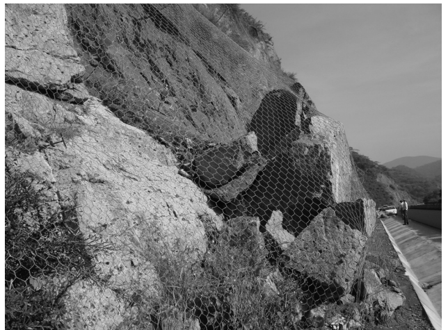
Fotografía 10.3 Comportamiento de mallas ancladas para sostener macizos de roca.
