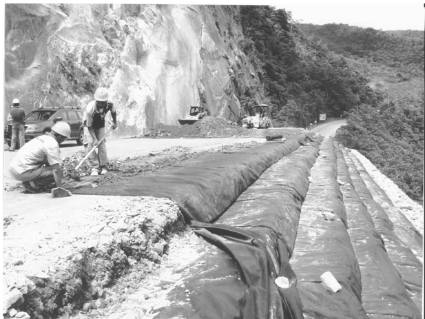
Amortiguación de grava con geotextil
