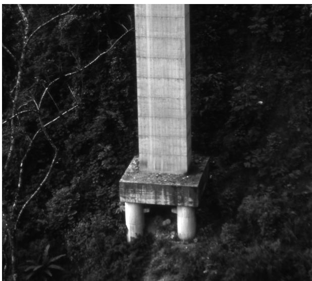
Fotografía 11.2 Uso de pilotes para la cimentación de la pila de un viaducto sobre un talud.
