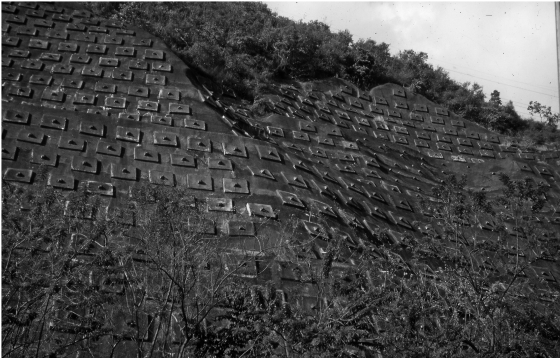
Fotografía 4.1 Muro con anclajes pretensados.
