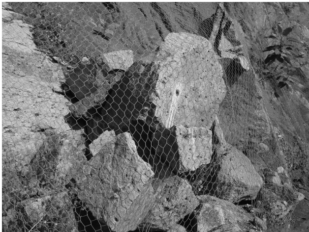
Fotografía 10.3 Comportamiento de mallas ancladas para sostener macizos de roca.
