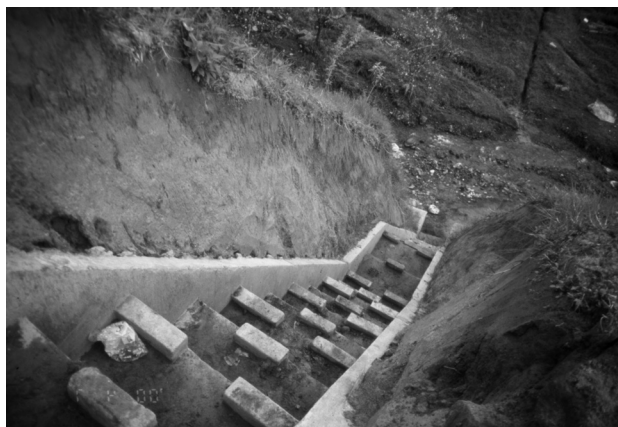
Fotografía 2.4 Torrentera en gradería con bloques de concreto.
