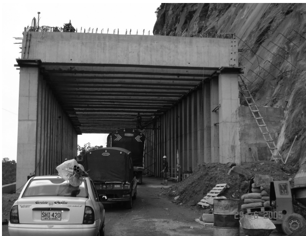
Vigas antes del tensionamiento
