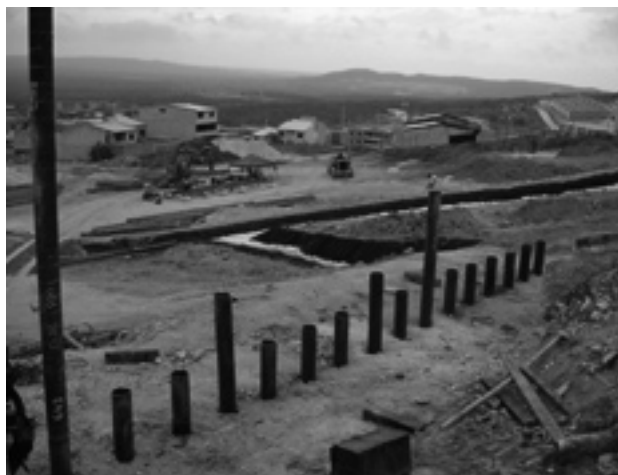
Fotografía 7.2 Pilotes metálicos hincados para estabilizar un deslizamiento.
