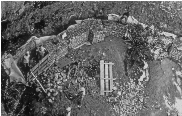
Fotografía 2.7 Pantallas de drenaje en gaviones.
