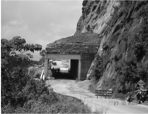
Fotografía 1.2 Túnel falso para disminuir el riesgo de los caídos de roca sobre los vehículos.
