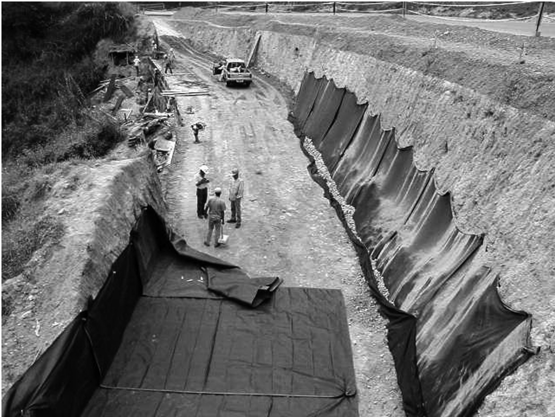
Fotografía 6.1 Construcción de un muro de tierra con refuerzo de geosintéticos.
