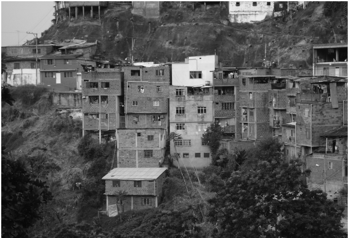
Fotografía 11.1 Las edificaciones sobre taludes.
