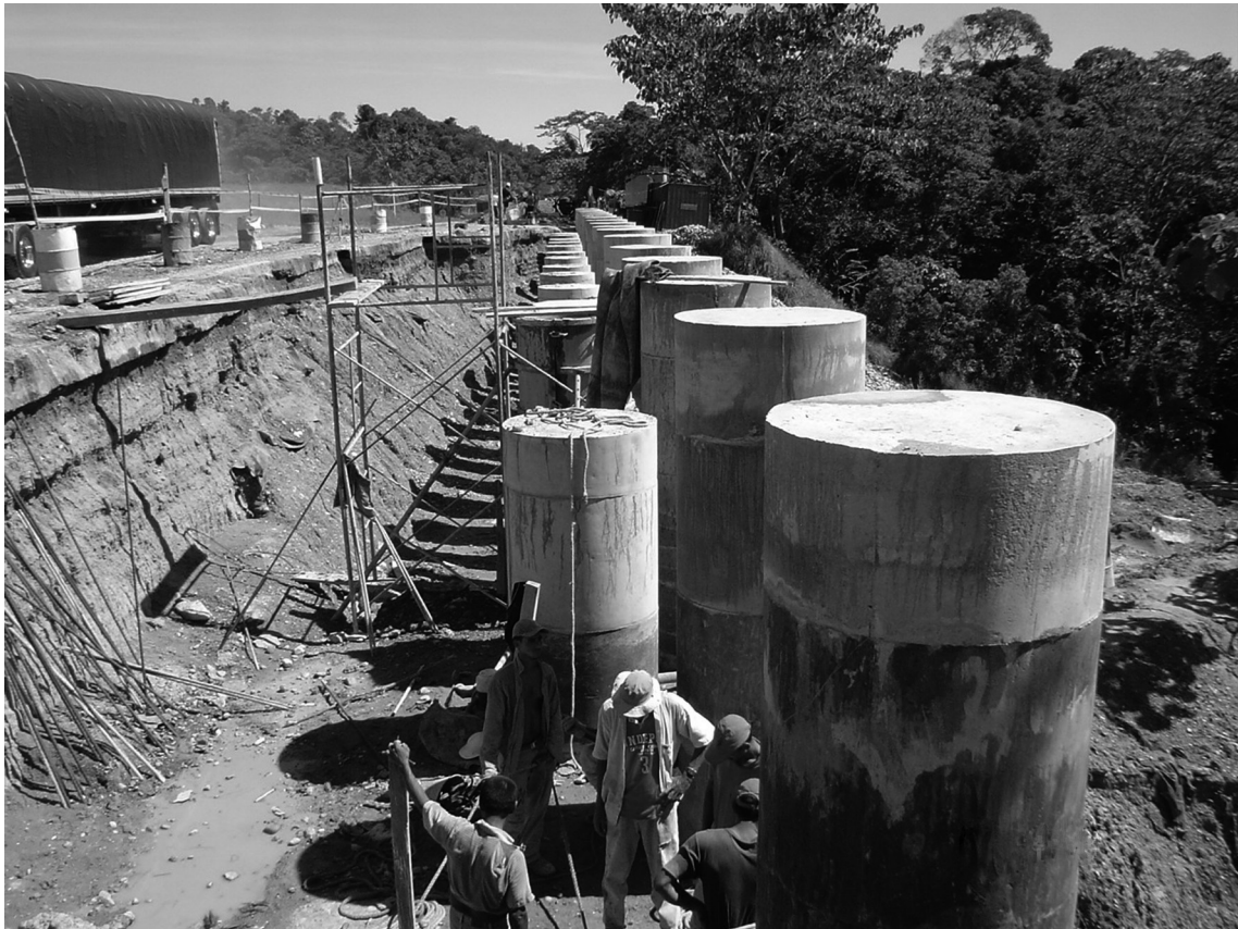
Fotografía 7.1 Construcción de un muro de pilas de concreto para la estabilización de un deslizamiento. Las pilas excavadas a mano tienen profundidad de 20 metros.
