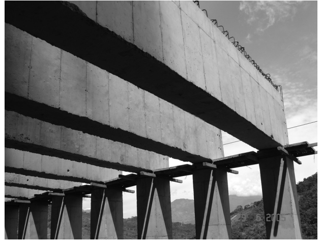
Colocación de vigas
