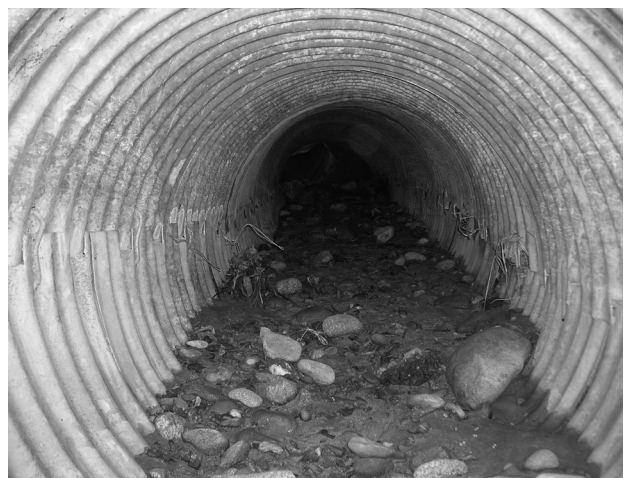
Fotografía 2.1 Para la estabilidad de los taludes es muy importante el mantenimiento y limpieza de las obras de drenaje y subdrenaje.
