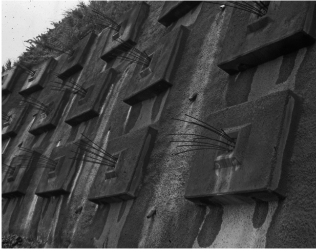
Fotografía 4.2 Muro - pantalla con zapatas.
