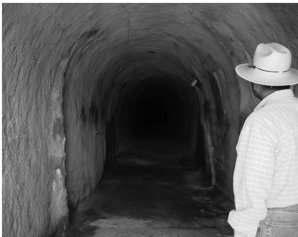
Fotografía 2.8 Túnel de drenaje para estabilizar el deslizamiento del estribo de un viaducto en la vía a Acapulco en México.
