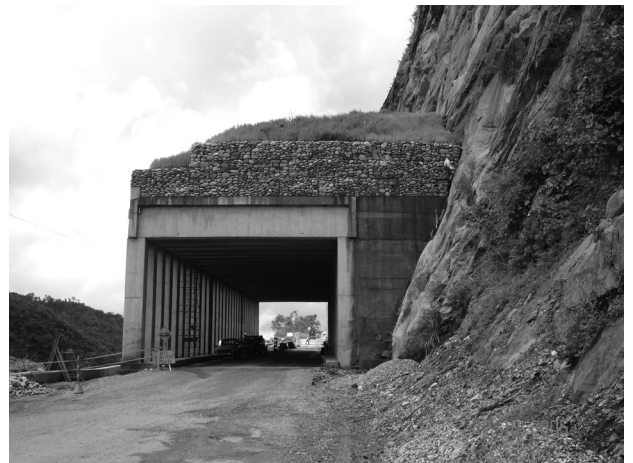
Túnel falso terminado
