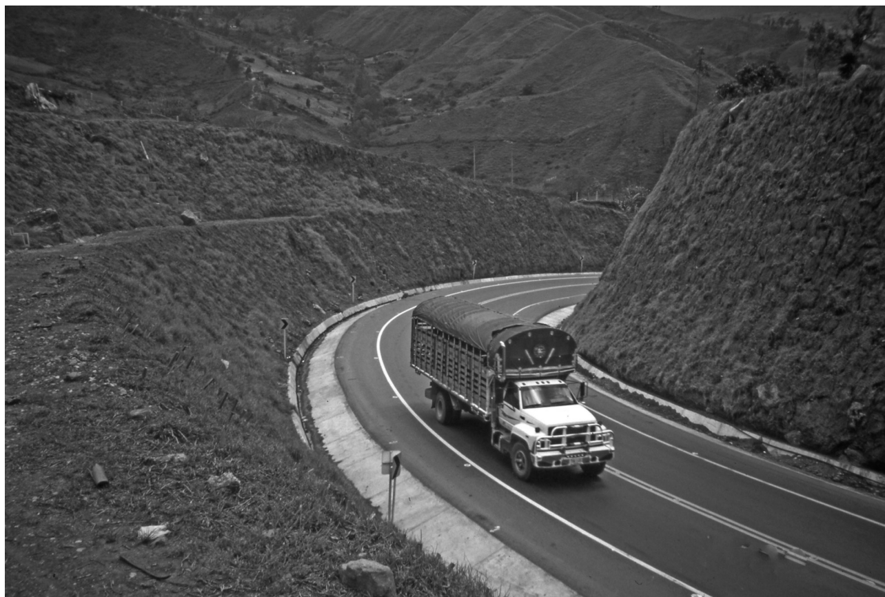
Fotografía 8.1 Conformación de los taludes de una vía. En el talud izquierdo el suelo es húmedo y se realizó un terraceo intermedio. En el talud derecho el suelo es seco y se cortó un talud de mayor pendiente.
