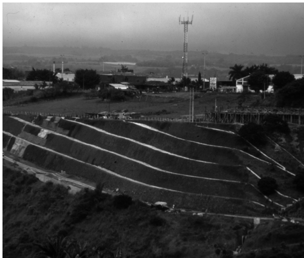
Fotografía 2.3 Canales interceptores a mitad de talud.
