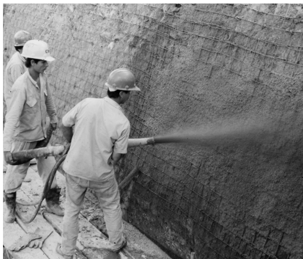
Fotografía 4.4 Colocación del concreto lanzado.
