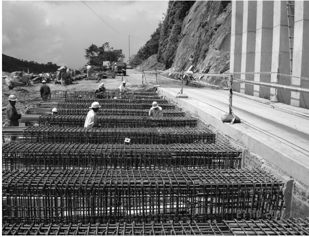
Construcción de la cimentación
