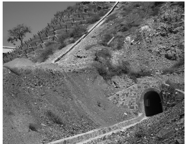
Fotografía 2.8 Túnel de drenaje para estabilizar el deslizamiento del estribo de un viaducto en la vía a Acapulco en México.
