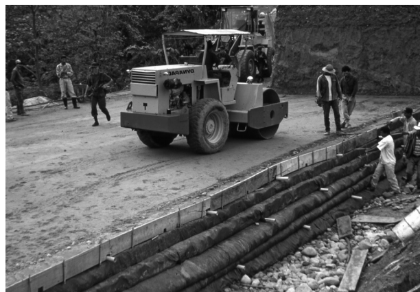
Fotografía 6.4 Proceso de compactación de un muro MSE.
