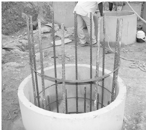
Fotografía 7.3 Construcción de pilas en forma manual para estabilizar un deslizamiento.
