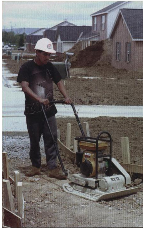
Foto 24: Compactador tipo Bandeja Vibratoria.
