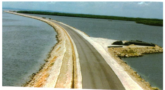
Foto 2: Vista de un pedraplén con finalidad vial.
