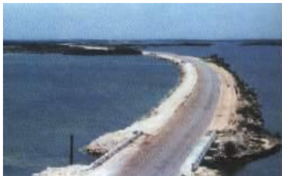
Foto 27: Pedraplén Caibarién-Cayo Santa María.
