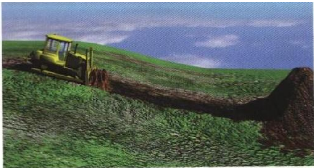
Foto 7: Buldózer trabajando a favor de la pendiente a distancias cortas
