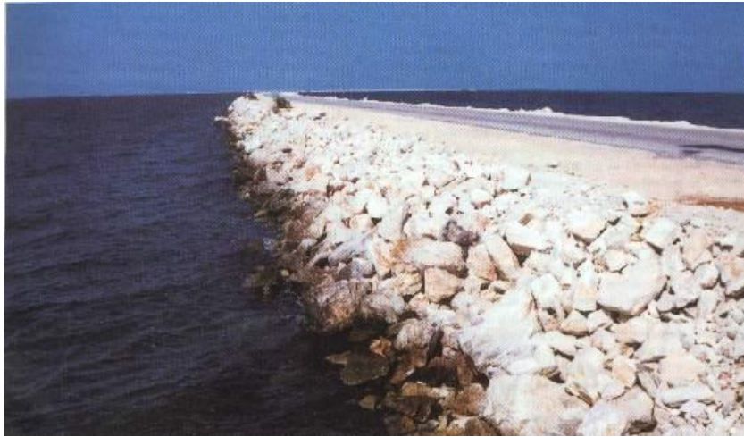
Foto 26: Pedraplén Caibarién-Cayo Santa María.
