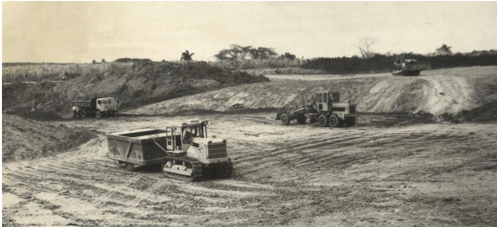
Foto 20: Compactador de Neumáticos de Remolque (CN), en la compactación de la cortina de la presa “Palmarito” en Villa Clara.
