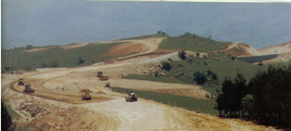
Foto 4: Vista del terraplén de una carretera rural.
