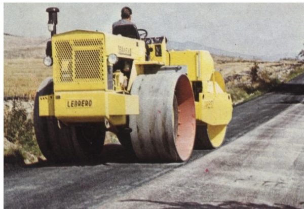
Foto 17: Compactador denominado Cilindro de llantas lisas (Triciclos).
