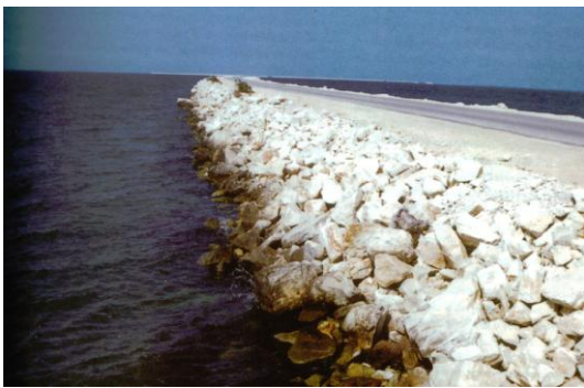
Foto 1: Escollera o coraza del pedraplén.
