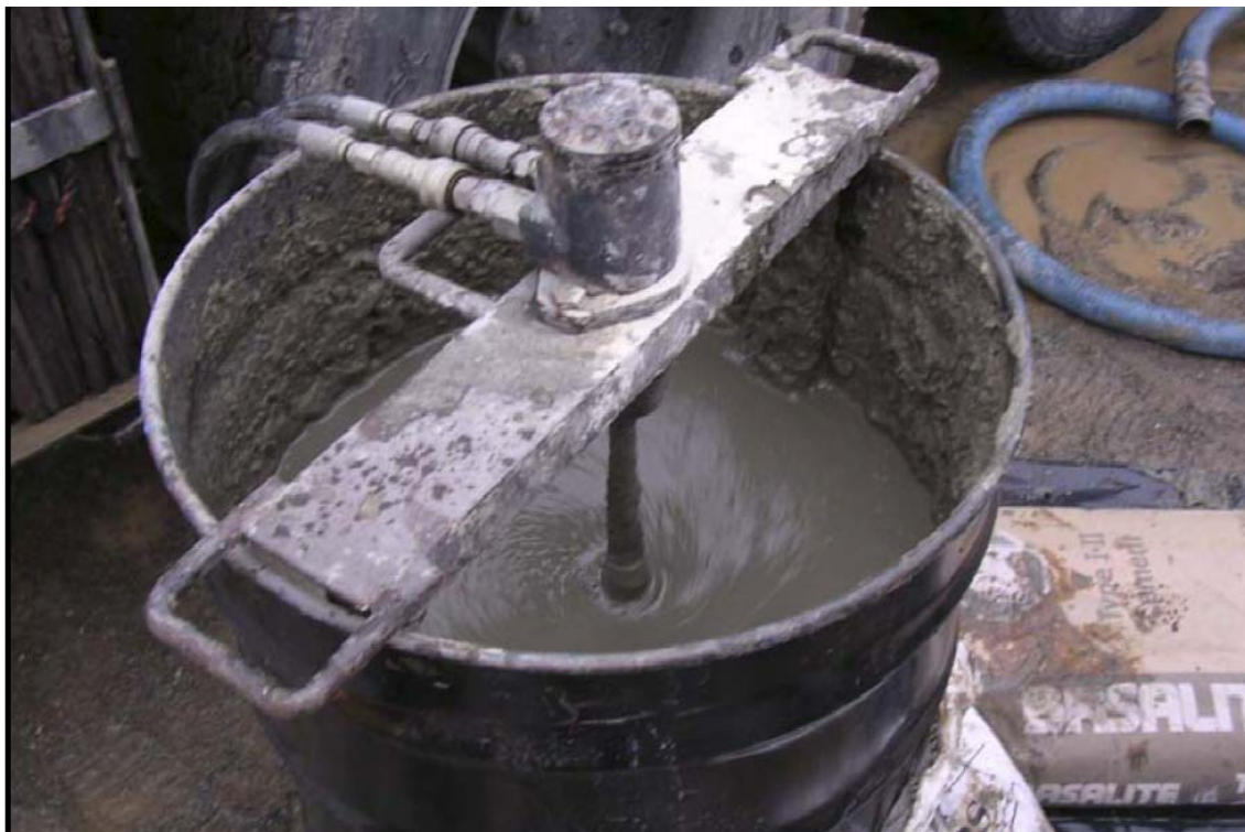
Figura 6.45 Mezclado de cemento-bentonita (Mikkelsen y Green 2003)
