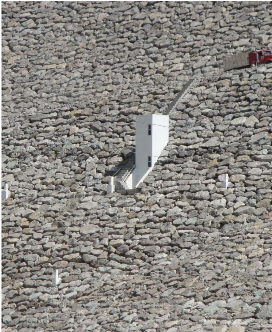
Figura 5.75 Caseta para la toma de lecturas de las celdas de asentamientos
