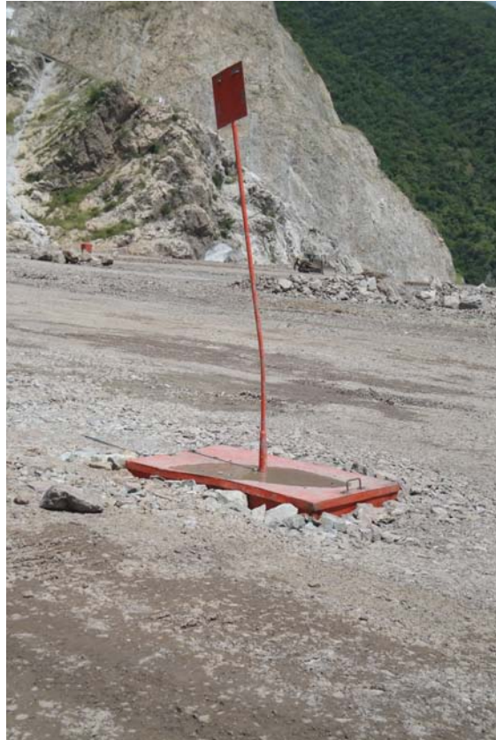
Figura 5.15 Caja metálica para la instalación de tubos guía del inclinómetro durante la construcción de un terraplén
