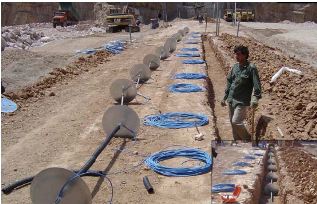
Figura 5.47 Instalación de un extensómetro interno de placas (cortesía de Sisgeo)
