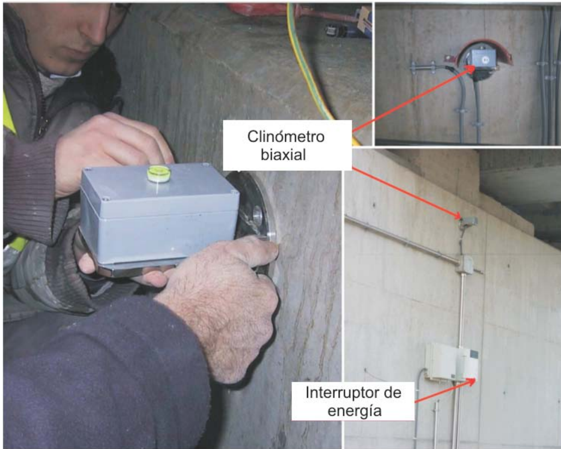
Figura 5.36 Instalación de un clinómetro (cortesía de Sisgeo)
