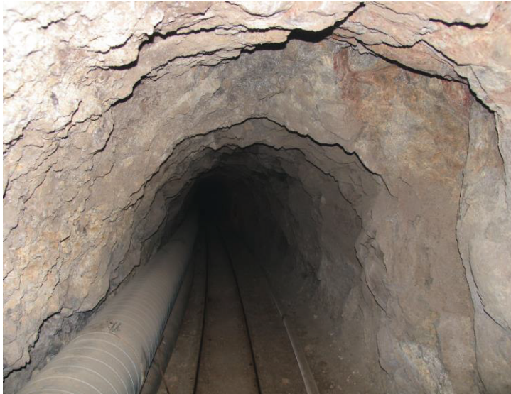
Figura 1. Sección de una galería en Tenerife.
