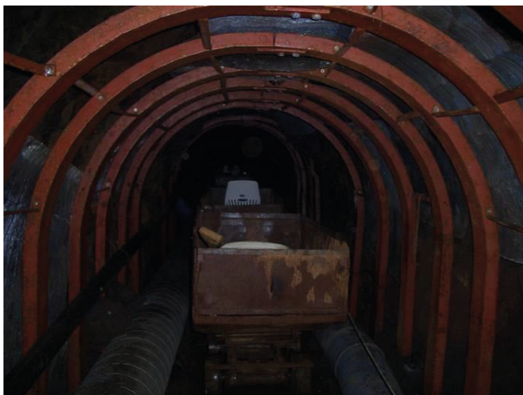
Figura 5. Fortificación mediante perfiles mecánicos arriostrados.
