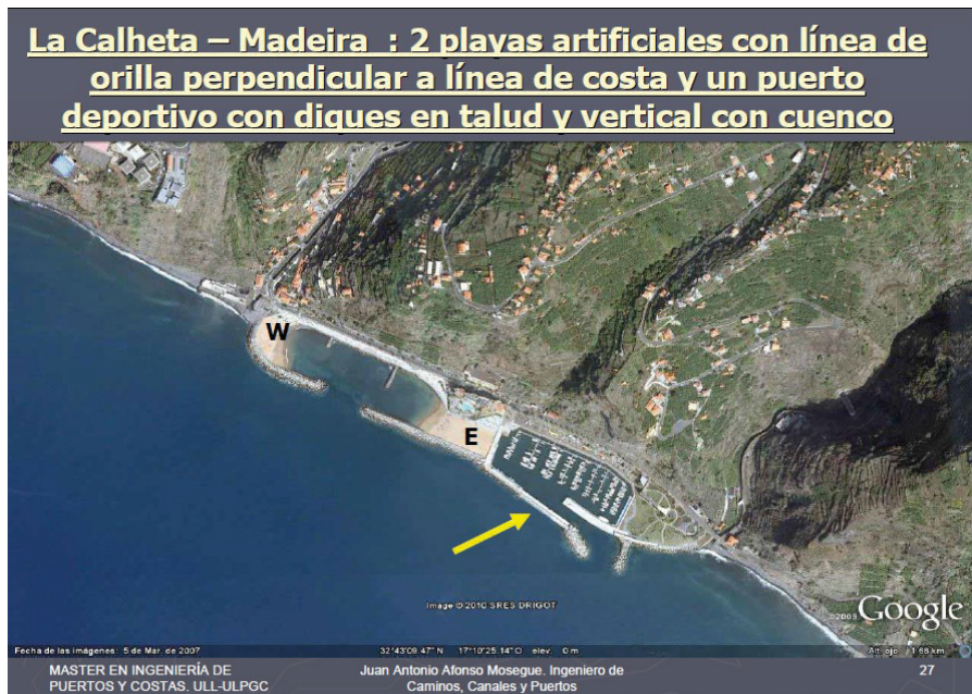
Figura 15. Infraestructuras marítimas construidas en La Calheta (Madeira).
