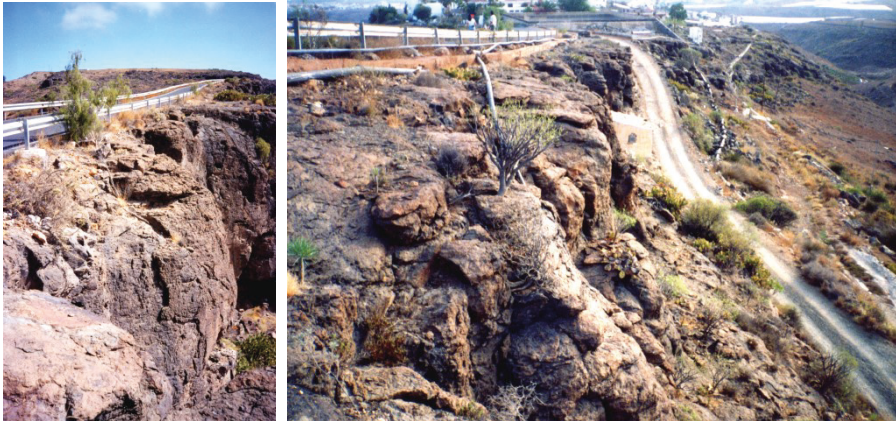
Figuras 3 y 4. Detalle de los taludes del macizo rocoso de ignimbritas fonolíticas sobre cuya coronación discurre la plataforma de la carretera.
