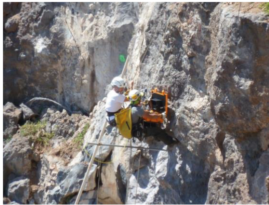
Figura 15. Auscultación de las perforaciones mediante videocámara.
