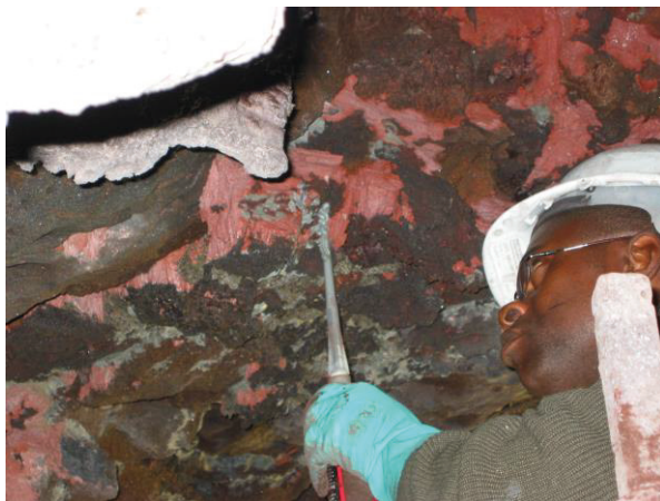
Figura 25. Instalación manual de la resina mediante cánula.
