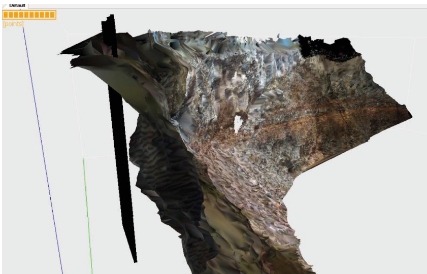
Figura 17. Vista en perspectiva del Modelo 3D de la parte superior de la ladera y representación del plano de una de las grietas abiertas con orientación paralela al talud.
