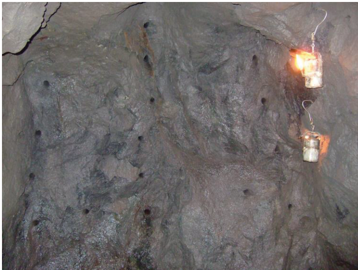
8. Perforación para voladura – Galería “Montaña Enmedio” (Tenerife)
