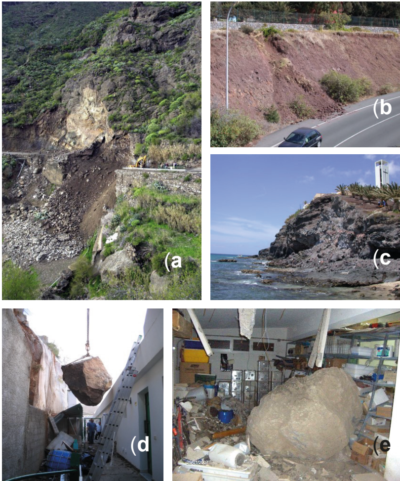
Figura 9. Algunos casos de deslizamientos y desprendimientos recientes en Canarias: (a) Carretera Tejeda-Arteara, Gran Canaria. Fuente: La Provincia (marzo 2006); (b) entrada 4 Campus Universitario de Tafira, Gran Canaria (agosto 2006); (c) Morro Jable, Fuerteventura (febrero, 2005); (d) bloque rocoso de 12 toneladas caído sobre unos apartamentos, Gran Canaria (diciembre, 2005); (e) caída catastrófica de bloques rocosos sobre las instalaciones del Centro Oceanográfico de Tenerife (enero, 2007).
